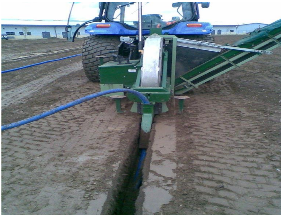
Εικ. 6 διάνοιξη αυλάκων αρδευτικού δικτύου
