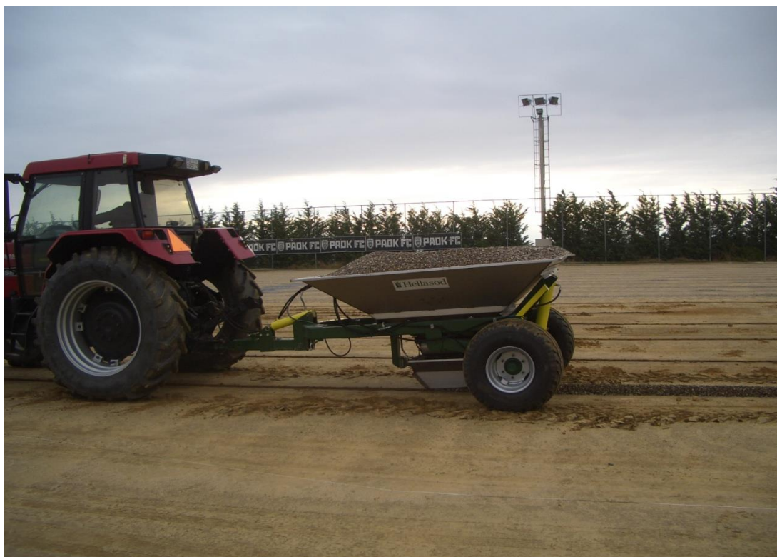
Εικ.5 Πλήρωση αυλάκων σωλήνων αποστράγγισης
